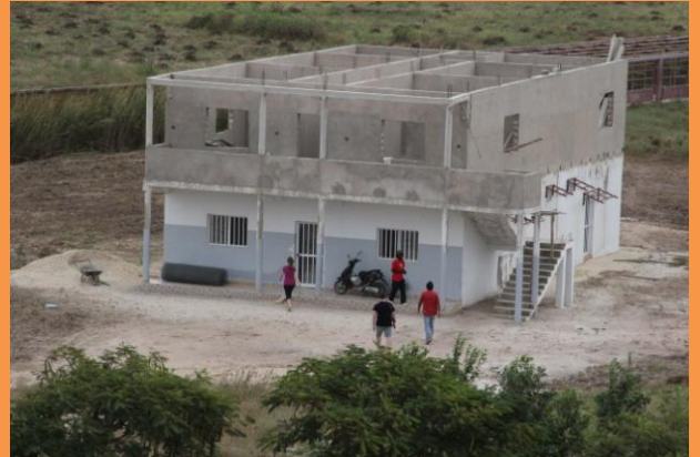
Mais um andar sendo construído
